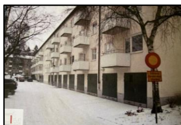
Rad med bevarade, ursprungliga garageportar. Sicklingsvägen 2 -10
