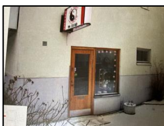
Den f.d fiskaffären på Bordsvägen 58 har fått 2 nya dörrar. Skyltfönstret har bevarats orört, i ursprungligt utförande
